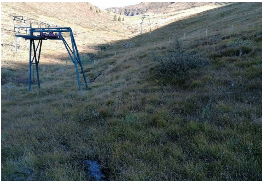
Abbildung 2.10: Die erste Stütze steht mitten im Feuchtgebiet
