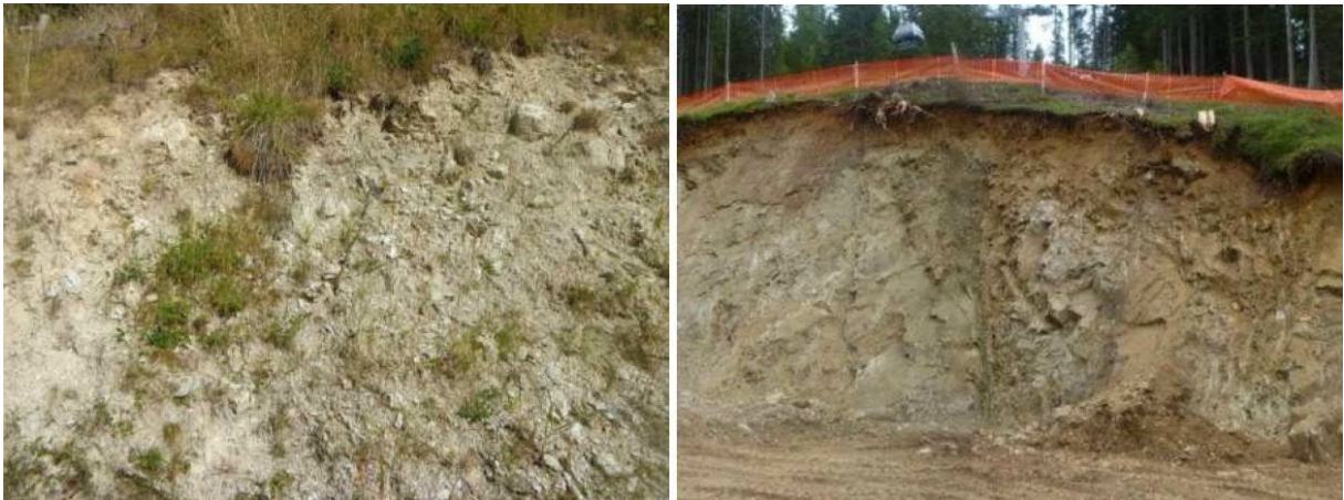
Abbildung 6.9: Links: Stark aufgelockerter und verwitterter Granit oberhalb der Almen „Gampen“; Rechts: Aushub an der Talstation Gaisjochbahn (Sommer 2011) in verwittertem bzw. stark zerlegtem Granit, im unteren Aushubabschnitt ist das ursprüngliche Felsgefüge größtenteils noch erhalten.
