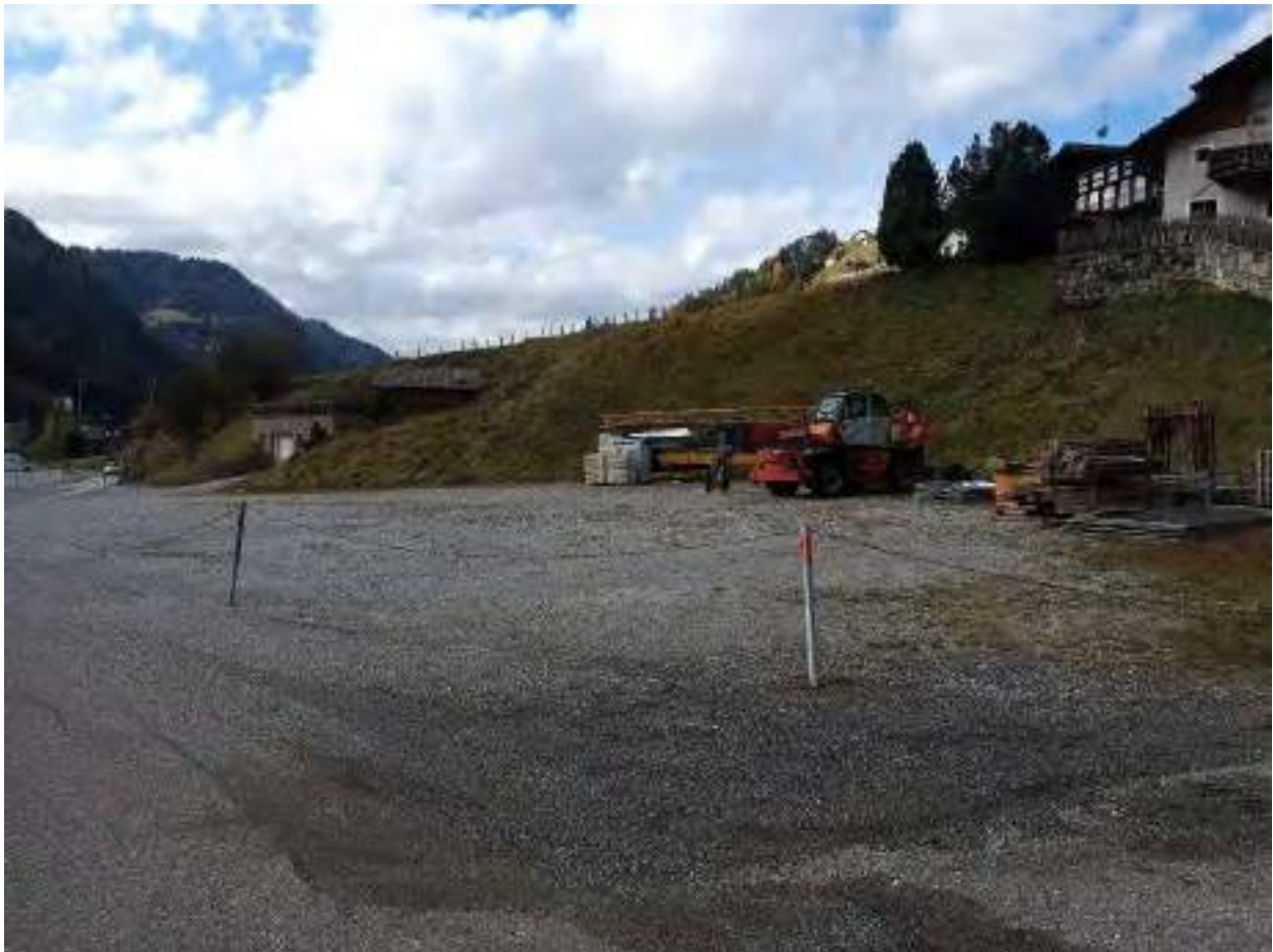
Foto 3 Bereich Talstation und Stütze W1
