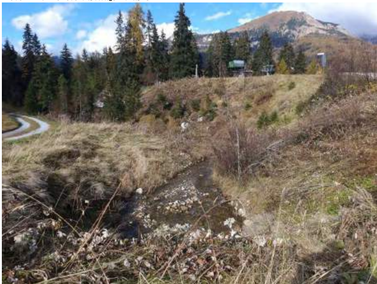
Foto 12 : Bereich Stütze Nr.S 8
