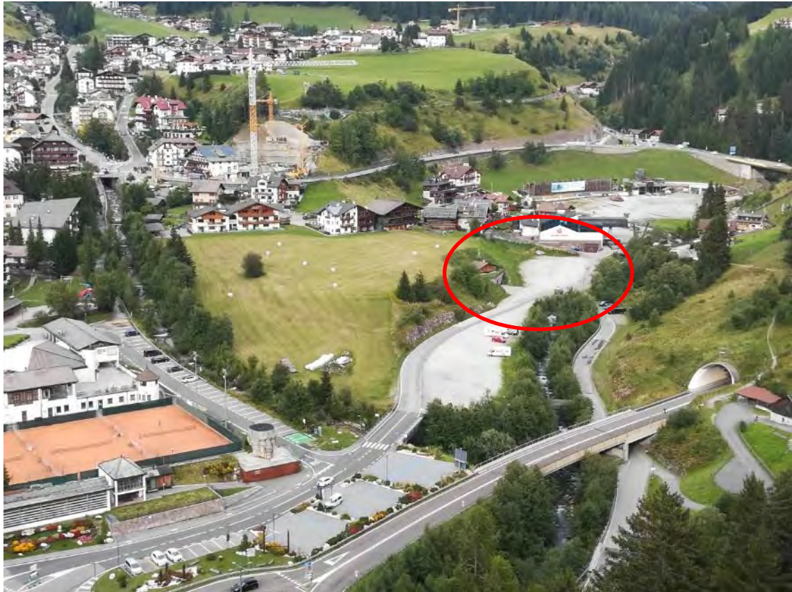
Stazione di valle | Talstation
