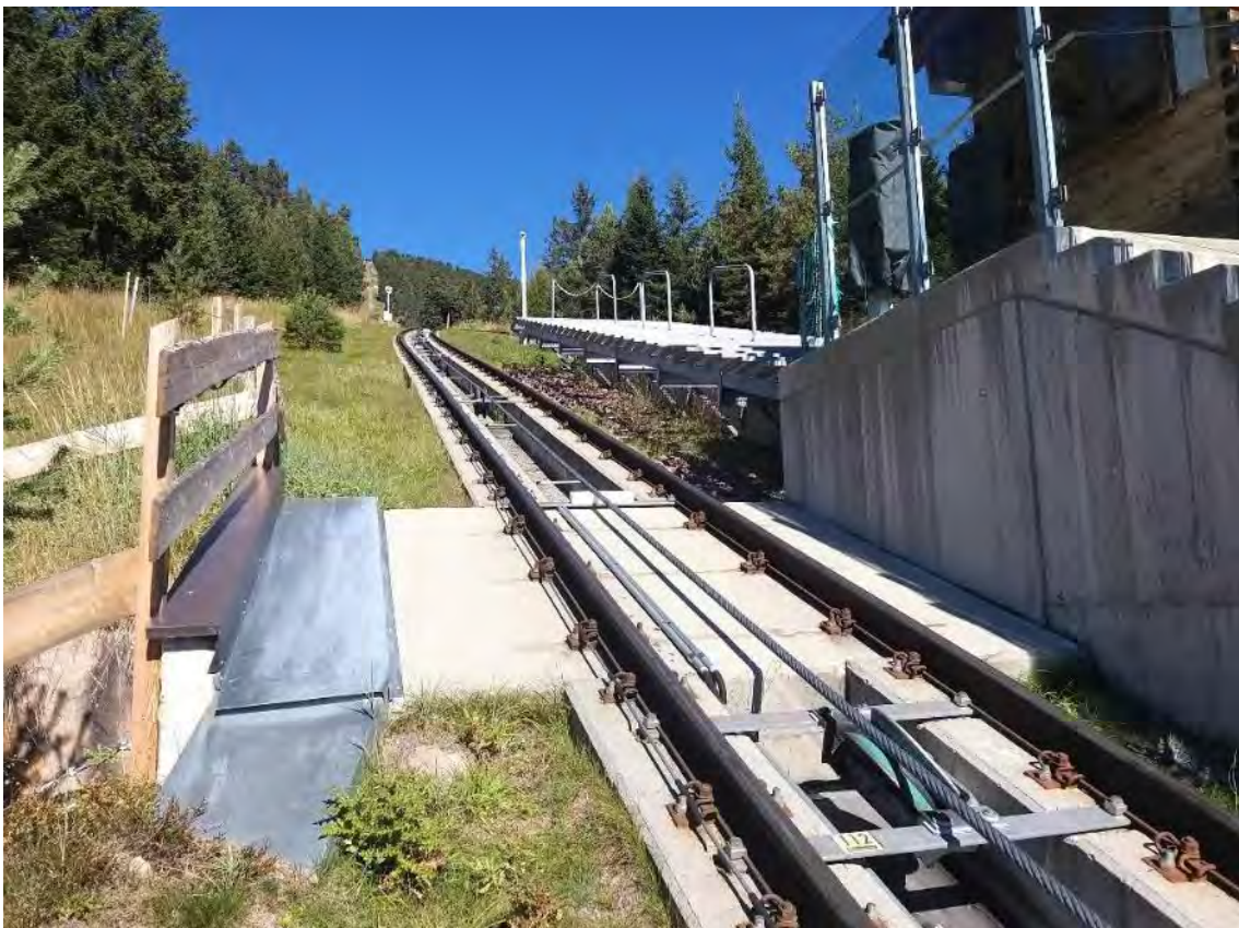
Le opere lungo la via di corsa prevedono la cementificazione di una porzione notevole di territorio.
