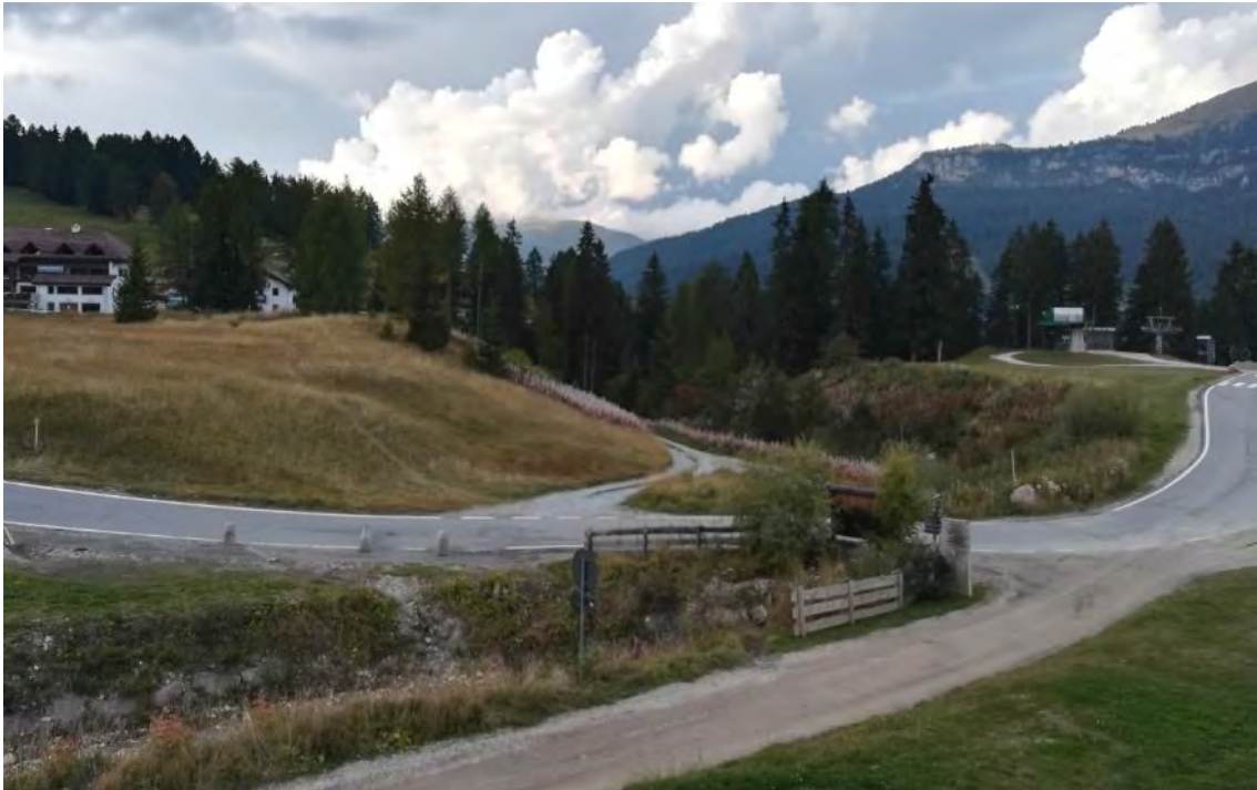
Veduta della zona interessata dalla realizzazione della stazione di monte dell'impianto RUACIA – MONTE PANA; a destra la stazione di monte dell'esistente seggiovia S. CRISTINA – MONTE PANA
