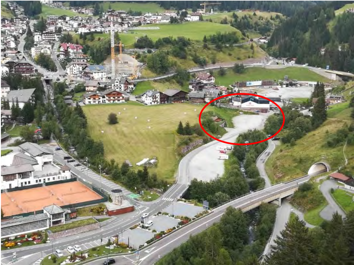
Veduta dall'alto della zona ove si ubica la stazione di valle, in prossimità dell'impianto SASLONG; in primo piano la SS242 della Val Gardena ed il Centro Iman, sulla sinistra
