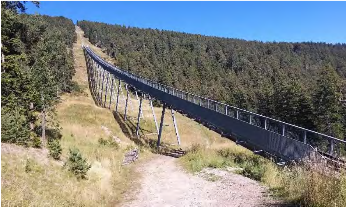
La realizzazione di un ponte sospeso andrà a mutare notevolmente la morfologia dei luoghi, in particolare tenendo conto del fatto che esso si staglierà di fronte all'abitato di S. Cristina. (Foto: funicolare del Resciesa, Ortisei)
