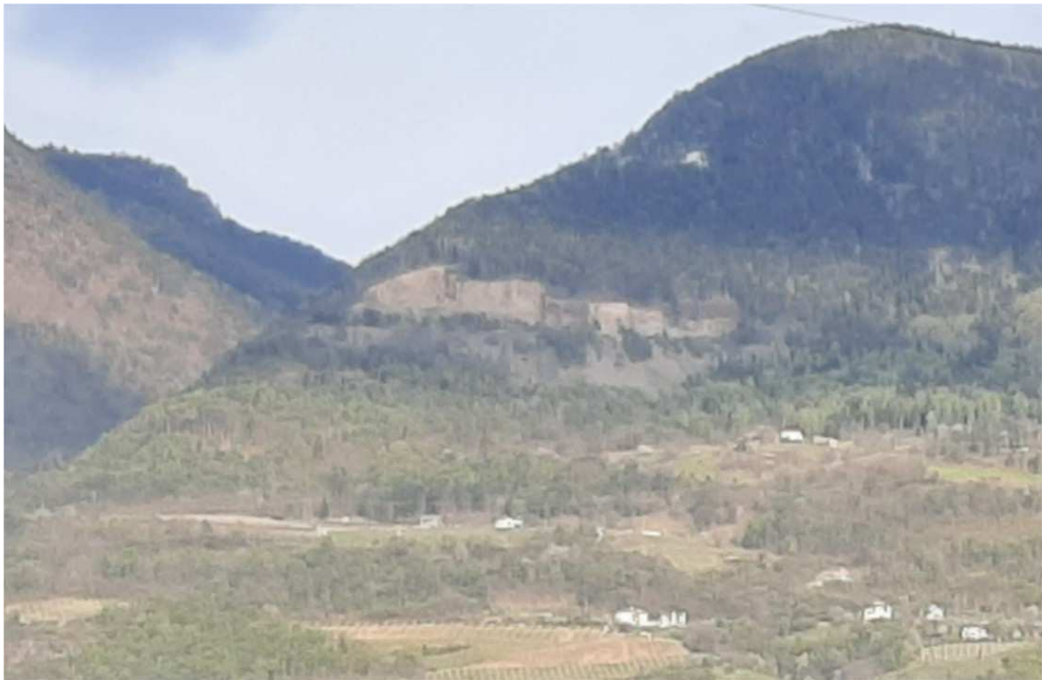
Aspetto attuale della Cava Flor vista dall'autostrada anno 2021
