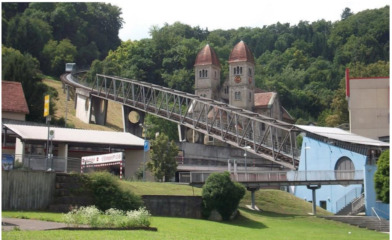
Bild 5: Standseilbahn Künzelsau – Bereich Talstation
