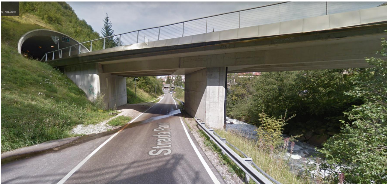
Bild 5: Brücke Monte Pana der Umfahrungsstraße von St. Christina – Blickrichtung Westen
