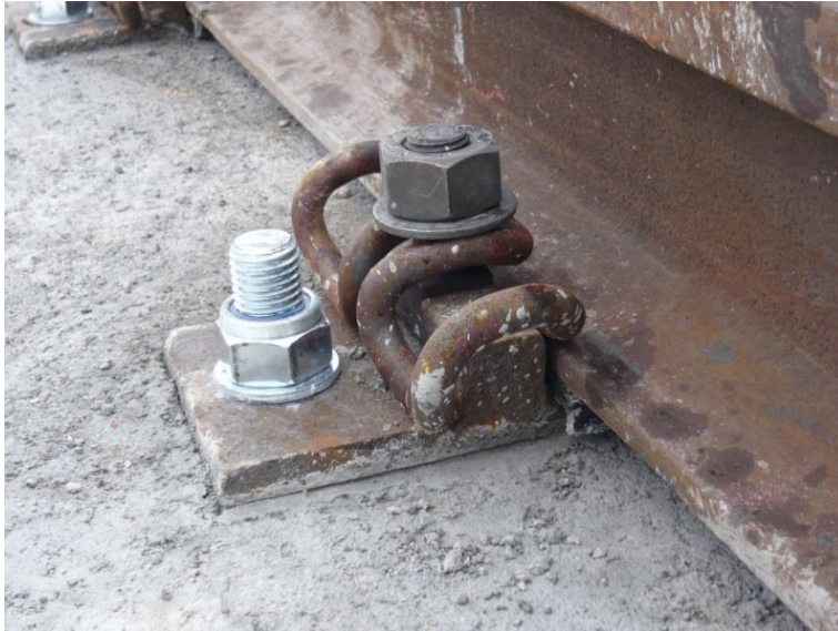
Bild 2: Schienenbefestigung auf Stahlbetonuntergrund
