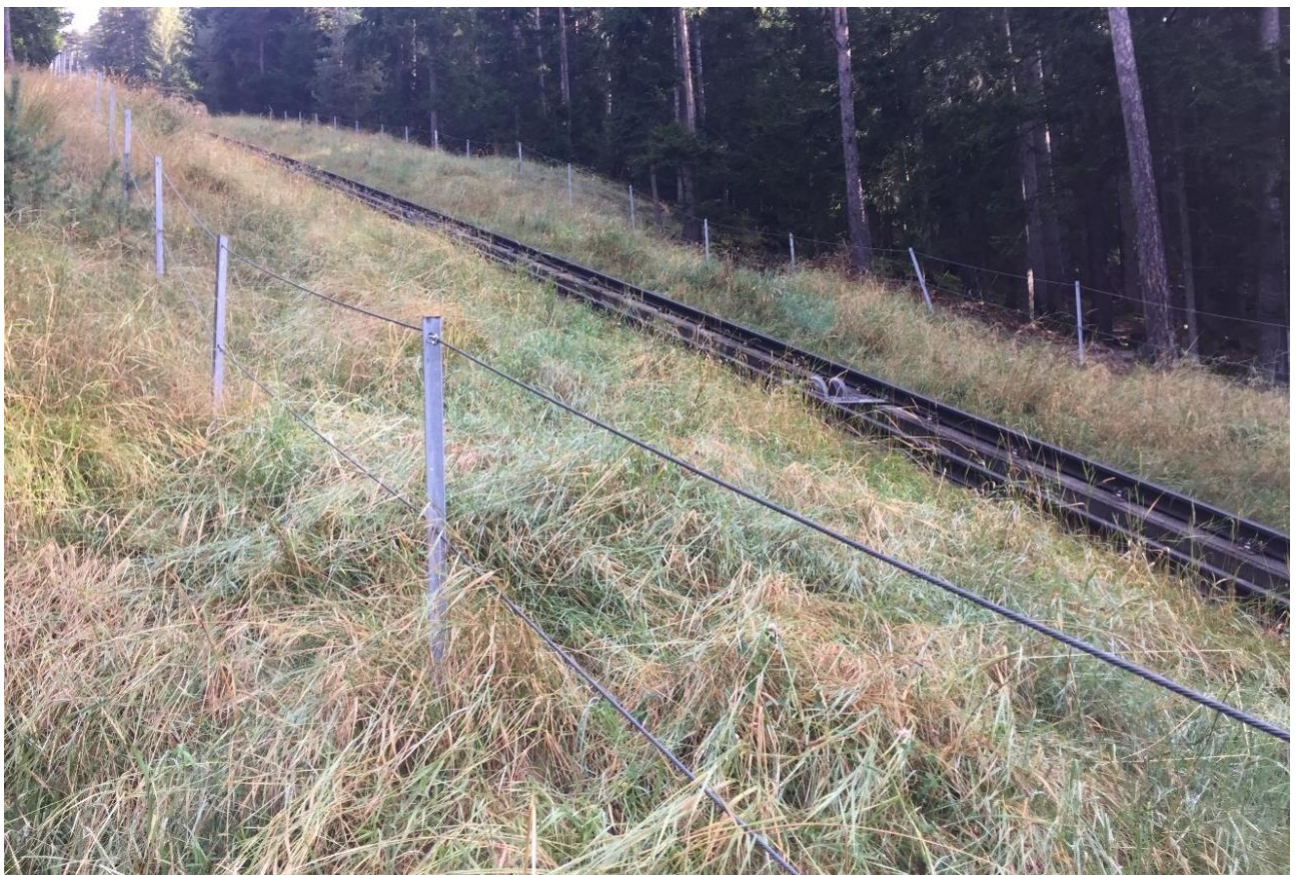
Abb. 9: Sicherungsmaßnahme Standseilbahn Raschötz
