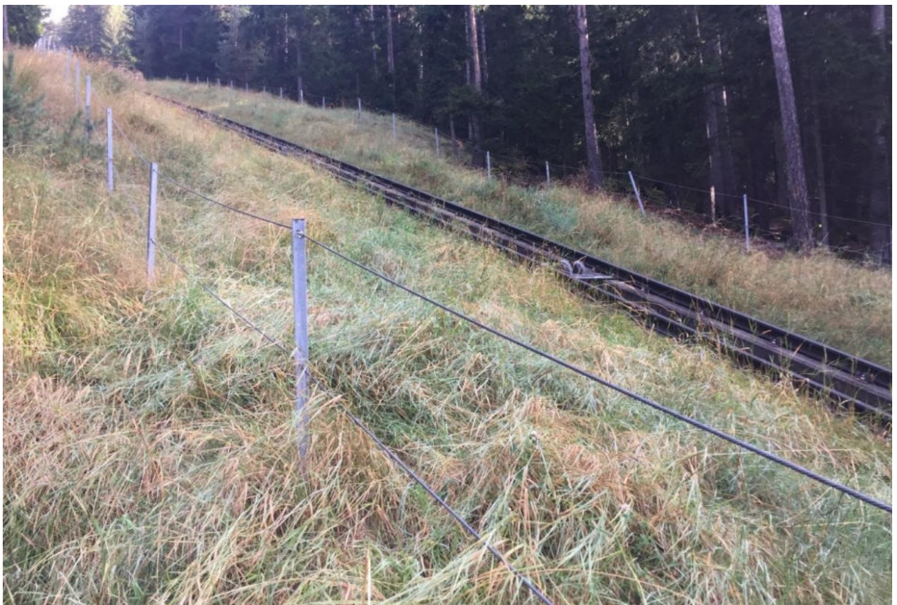
Abb. 9: Sicherungsmaßnahme Standseilbahn Raschötz
