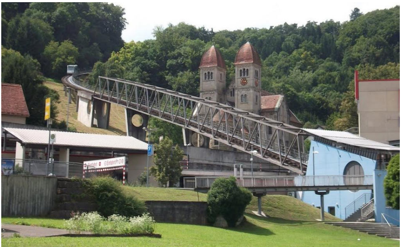
Bild 5: Standseilbahn Künzelsau – Bereich Talstation
