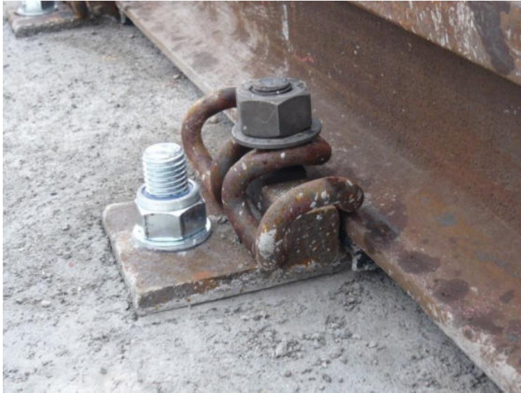
Bild 2: Schienenbefestigung auf Stahlbetonuntergrund
