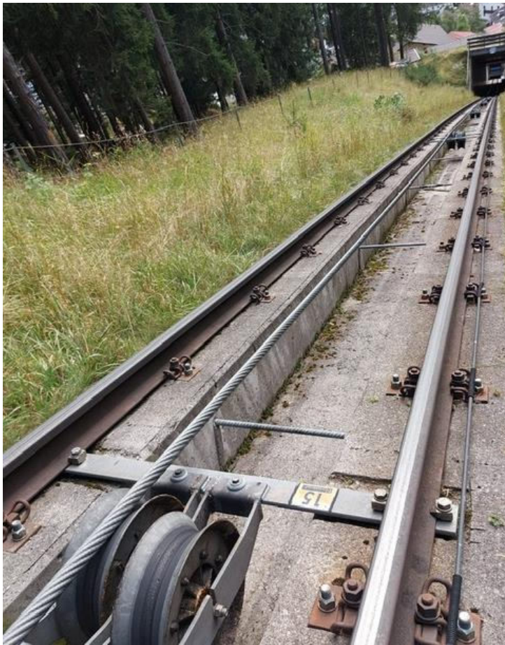
Bild 4: Gleisführung in der freien Strecke
