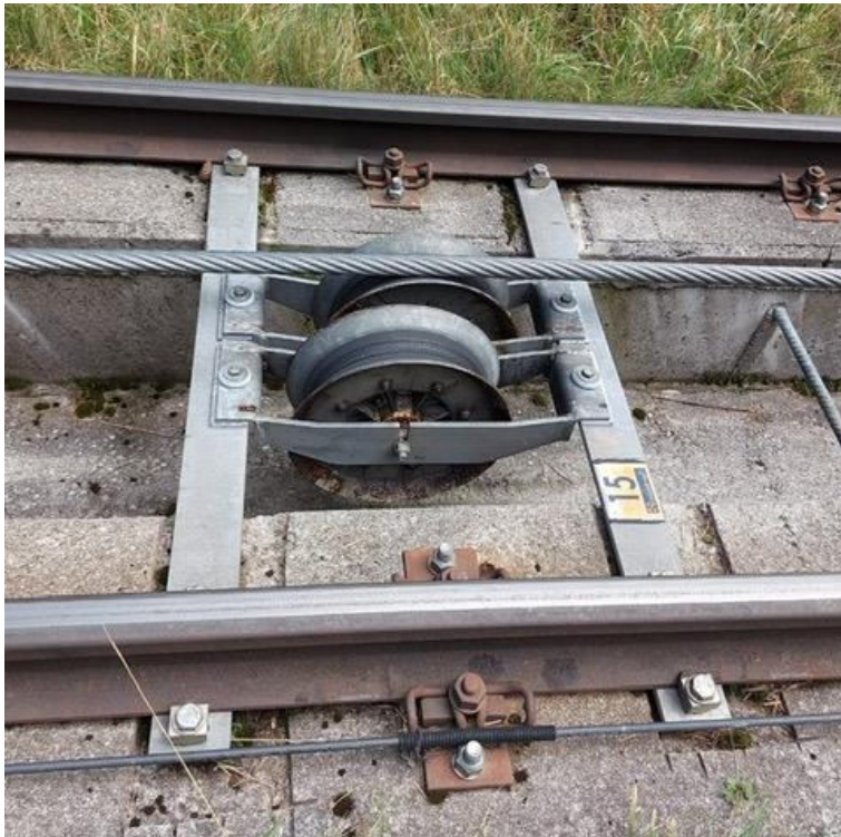
Bild 3: Streckenseilrollen mit getrennter Befestigung auf Stahlbetonuntergrund
