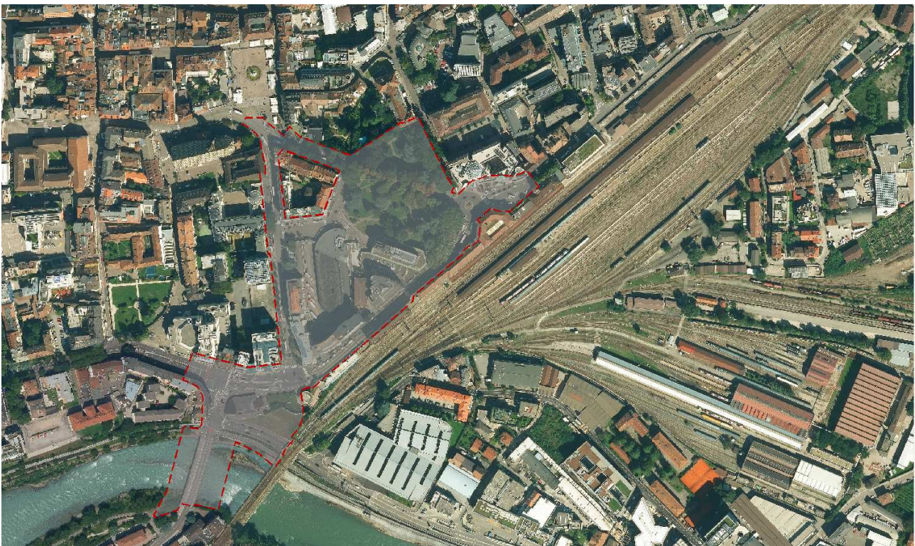
Abbildung 2: Abgrenzung Untersuchungsraum städtebaulich-architektonisches Kriterium
