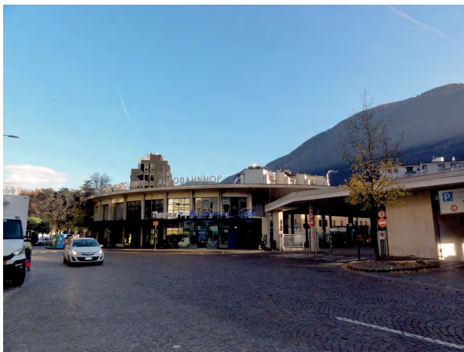
Figura 57: uscita della stazione degli autobus su Via Perathoner
