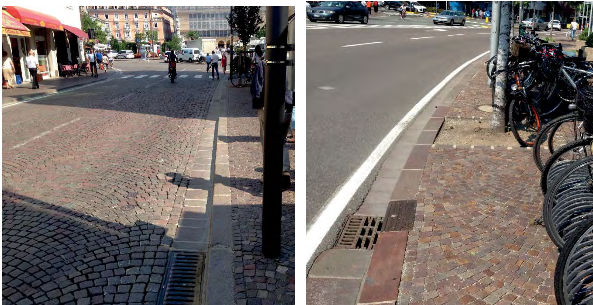
Figura 41: Tipische Situationen Regenwassereinflüsse Bestand
