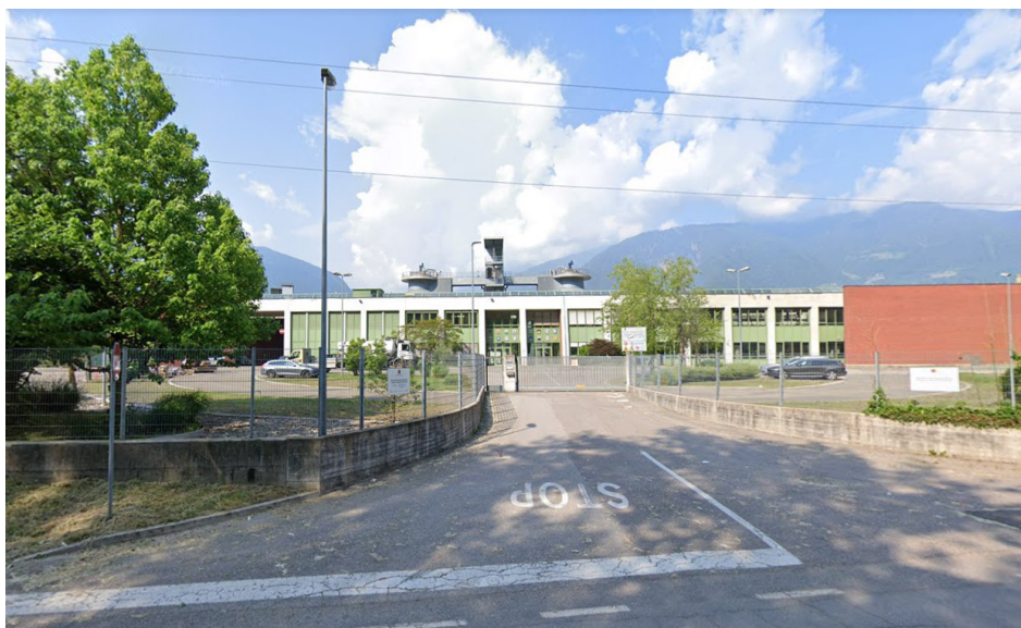
Accesso principale da SS38
