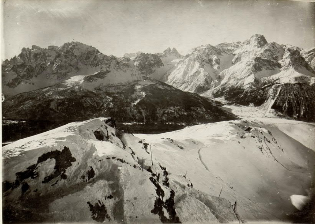
Abbildung 10.12: Blick vom Hornischeck auf die Stellungen auf Tonrast
