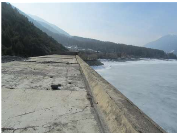
Abb. 4 – Blick vom Dach der Galerie Richtung See Fig. 4 – Vista dal tetto della galleria verso il lago
