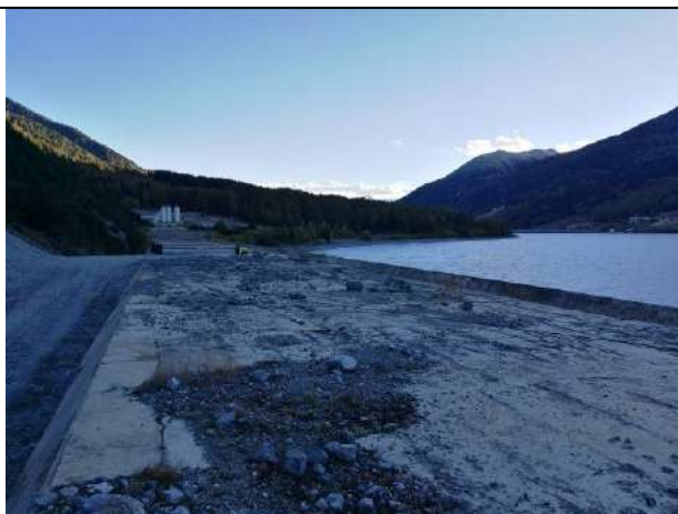
Abb. 2 – Dach der Galerie Fig. 2 – Tetto della galleria
