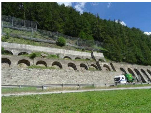
Abb. 8 – Bestehende Steinschlagschutzbauten im nördlichsten Teil des Untersuchungsgebietes (Fotodokumentation des GZP Graun im Vinschgau).
