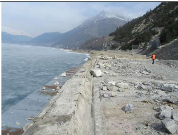
Abb. 6 – Blick vom Dach der Galerie Richtung See Fig. 6 – Vista dal tetto della galleria verso il lago
