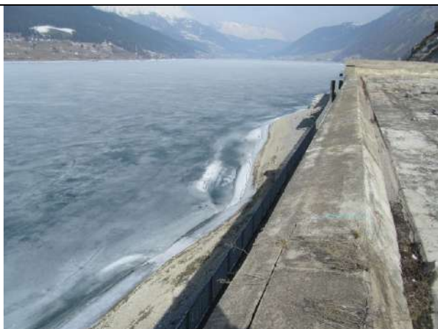
Abb. 3 – Blick vom Dach der Galerie Richtung See Fig. 3 – Vista dal tetto della galleria verso il lago
