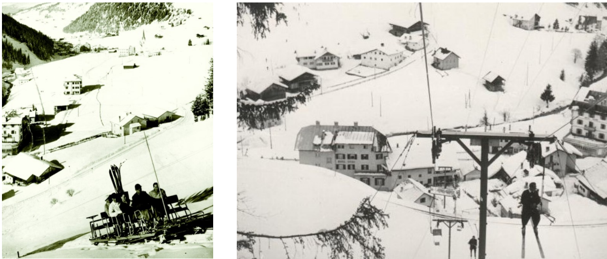
Figura 1: storici impianti del collegamento COSTABELLA
