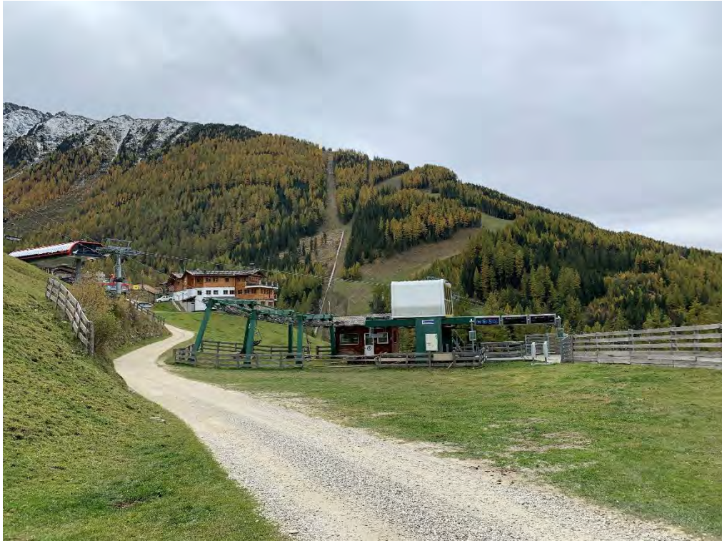
Foto 7: Alte Talstation SONNENLIFT und oberster Bereich der Skipiste TALABFAHRT kurz vor Erreichen der Unterführung TALABFAHRT – Vecchia stazione di valle SONNENLIFT e prima parte della pista TALABFAHRT poco prima del raggiungimento del sottopasso
