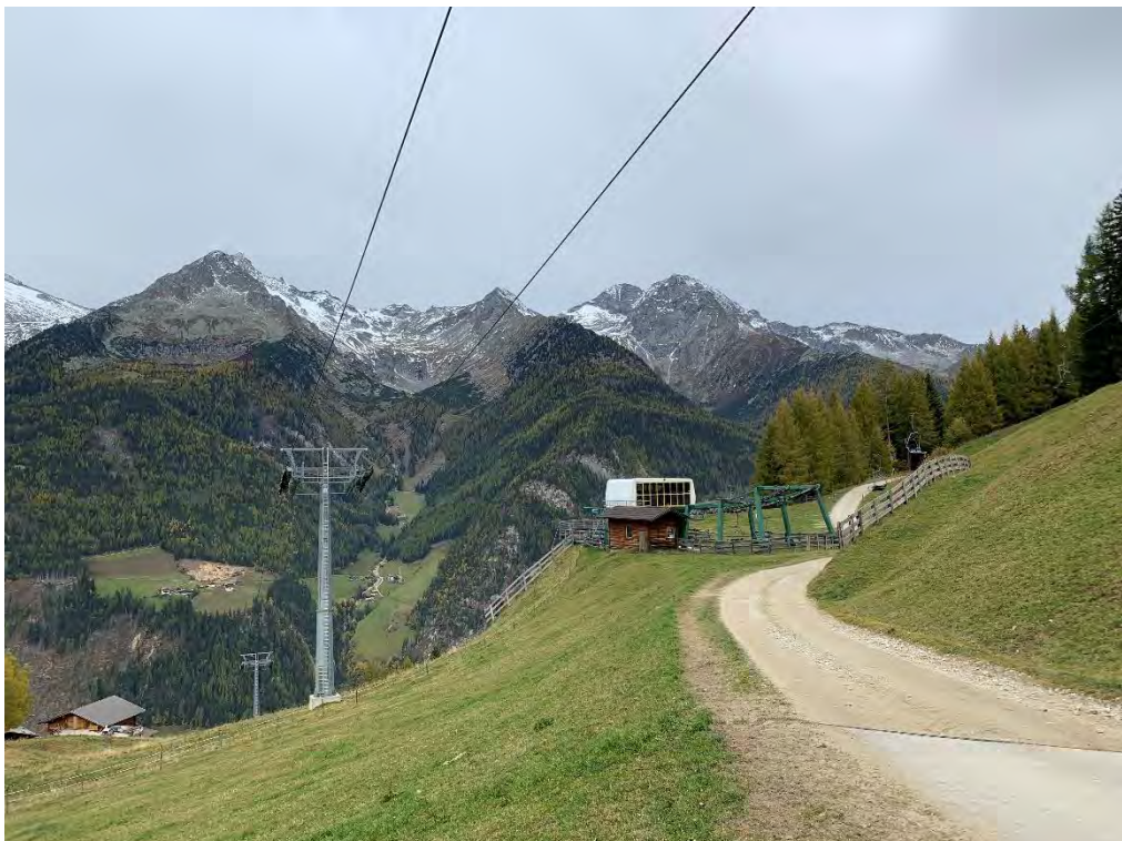
Foto 4: Abzubrechende Talstation SONNENLIFT – Stazione di valle SONNENLIFT da demolire
