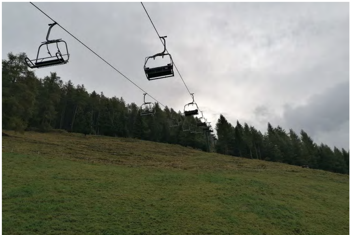
Foto 10: Abzubrechende Anlage SONNENLIFT mit Aufforstung der Waldschneise – Impianto SONNENLIFT da demolire con rimboscimento della fascia disboscata
