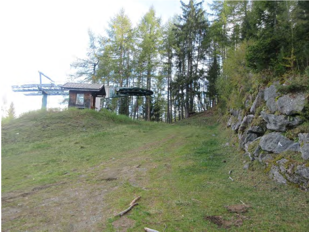
Foto 29: Abzubrechende Bergstation SONNENLIFT – Stazione a monte SONNENLIFT da demolire
