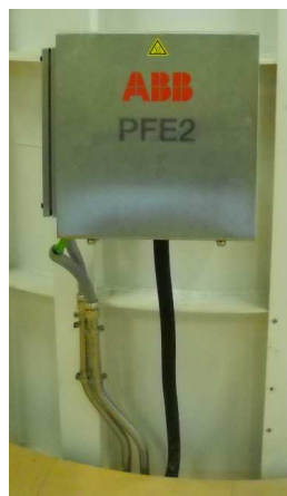
Unità filtro con box di protezione
