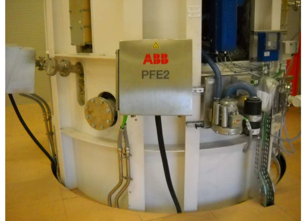
Dettaglio sonda prelievo Hg
