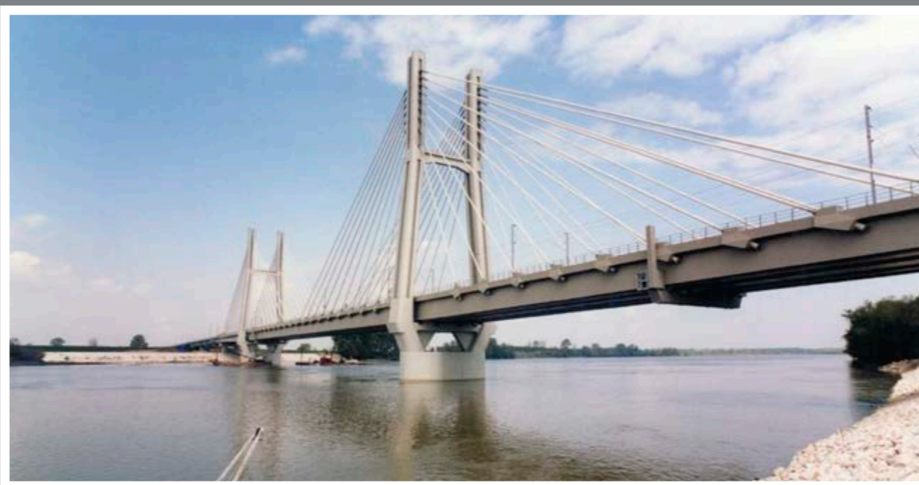
Ponte sul PO-Linea ferroviaria AV Bologna Milano
