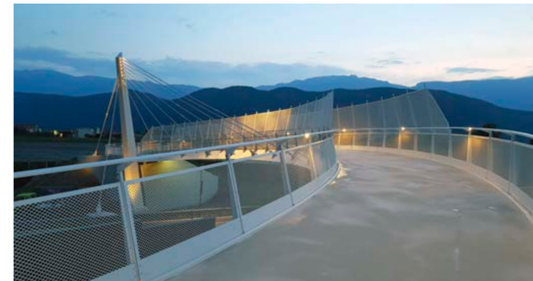
Geh- und Fahrradbrücke über die SS 12 in Steinmannwald in der Gemeinde Leifers / Ponte pedo-ciclabile sulla SS12 a Pineta di Laives. Photo credits: Autonome Provinz Bozen - Südtirol / Provincia Autonoma di Bolzano - Alto Adige / Simona Sedlak
