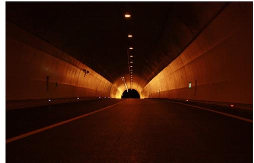
Im Zuge des Projekts wird in einem ersten Schritt der Stand der Technik zum Themenkomplex erhoben und bewertet. Aufgrund der gesammelten Daten werden helle Straßenbeläge entwickelt und in einem Tunnel eingebaut, ebenso wie innovative sparsame Beleuchtungssysteme und neue Technologien zur Beschichtung der Tunnelwände bzw. Tunnelleibung.
