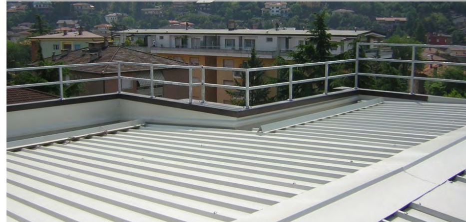
RIFACIMENTO MANTI DI COPERTURA E RELATIVA COIBENTAZIONE
