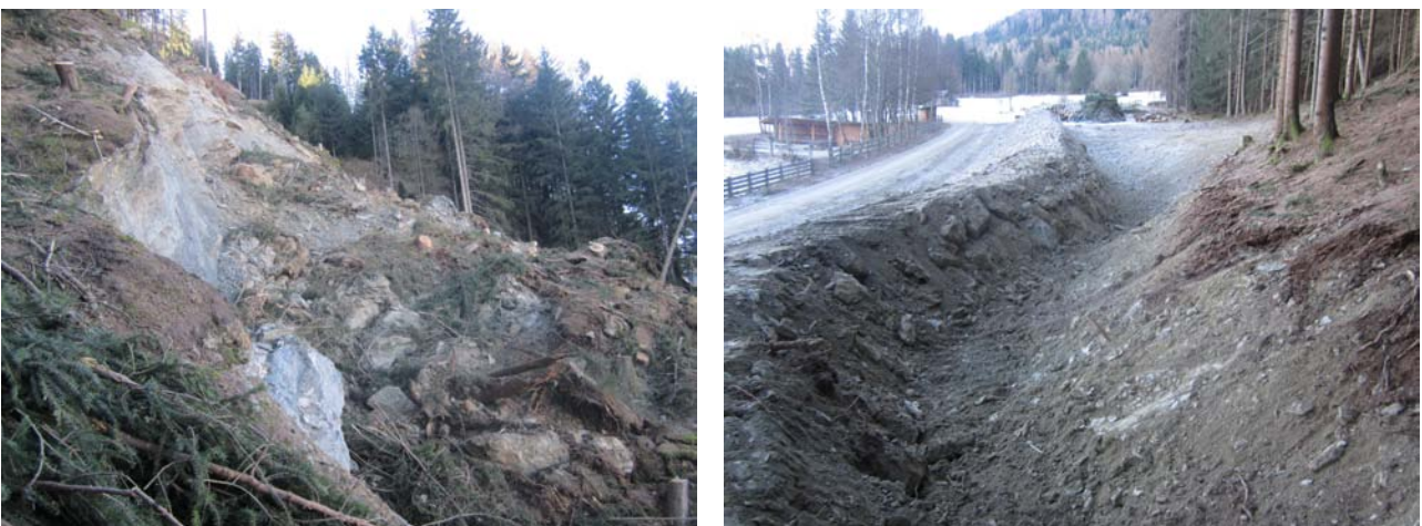
Abbildung 19: links: Anbruchkante der Felsgleitung, wobei sowohl Quarzphyllit als auch Lockermaterial aktiviert wurden. Rechts: einer der aufgeschütteten Schutzdämme am Hangfuß. Dieser hat inzwischen (Stand: Februar 2017) zahlreiche Sturzblöcke zurückgehalten
