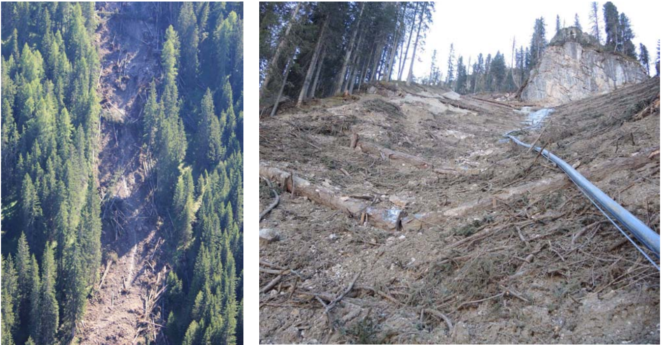
Abbildung 15: links: zentraler Bereich der Hangmure. Deutlich erkennbar ist die breiige Konsistenz des Materials; rechts: Stabilisierung der Hangmure mit ingenieurbioologischen Maßnahmen (Aufnahme Dezember 2016)
