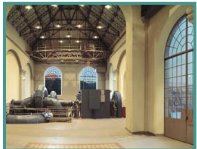
Foto/Bildnachweis: Azienda Energetica SpA-Etschwerke AG; in alto/oben: Centrale Bolzano a Cardano/Kraftwerk Bozen in Kardaun; le altre due foto mostrano la Centrale Tel/die beiden anderen Bilder zeigen das Kraftwerk Töll
