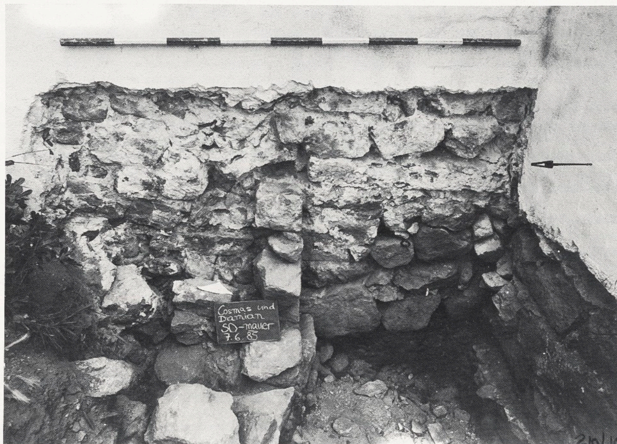
Abb. 7 Cosmas und Damian in Siebeneich. Blick von Süden auf die Südmauer der vorromanischen und romanischen Mauerstruktur. Links die Zargen des frühmittelalterlichen Querannexes, der Pfeil gibt die Trittstufe einer späteren Erhöhung an.
