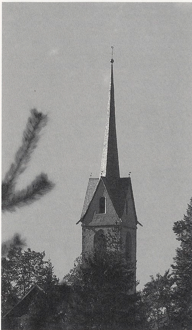
Gummer, Pfarrturm nach der Neudeckung mit Lärchenschindeln San Valentino in Campo, campanile della chiesa parrocchiale dopo la ricopertura con scandole di larice
