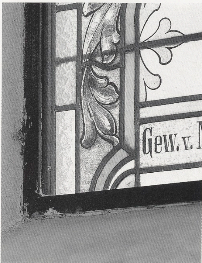
Kortsch, Pfarrkirche, Schutzverglasung innen
