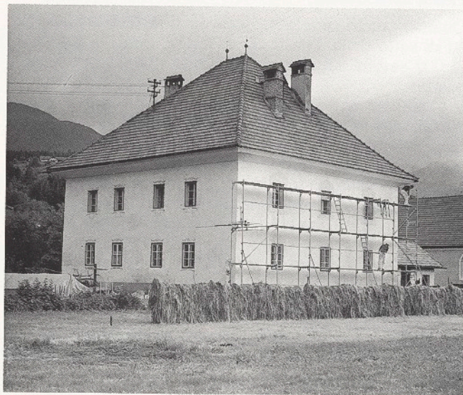
St. Lorenzen, Widum Hl. Kreuz vor und nach der Fassadenrestaurierung S. Lorenzo di Sebato, canonica di Santa Croce prima e dopo il restauro delle facciate
