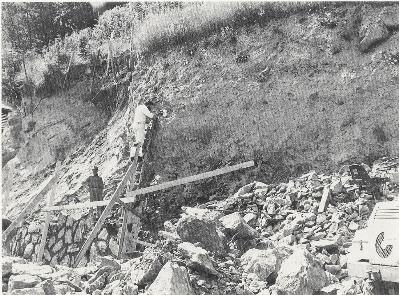
Villanders, St. Stephan. Die Bergung der Reste des römerzeitlichen Brandgrabes, die hoch auf der steilen Hangböschung der Baustelle geblieben sind. Villandro, Santo Stefano. Il recupero dei resti della tomba romana a cremazione rimasta isolata in alto nella ripida scarpata del cantiere.
