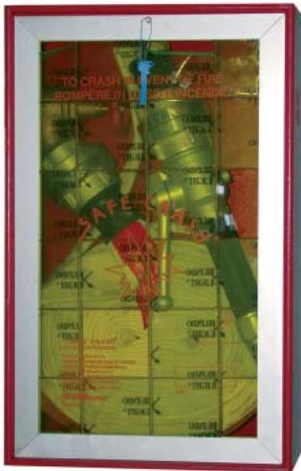
Abb. 14 Wandhydrant - für kleine Siloanlagen kann ein Wandhydrant ausreichend sein.
