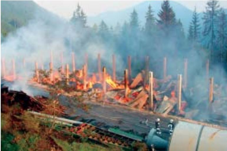
Abb. 3 Größere Feuerbeständigkeit der Stützen im Gegensatz zu den Trägern
